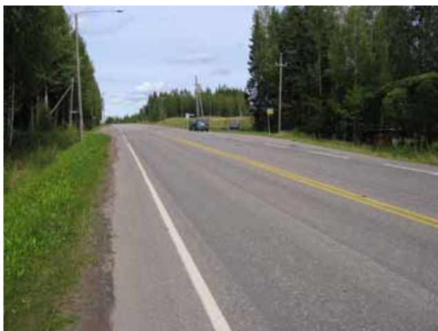
■ Kuva 6.15. Nykyinen maanvastaanottoalueen liittymä vasemmalla ja Tuomenojankadun liittymä oikealla (kuva etelän suunnasta).
