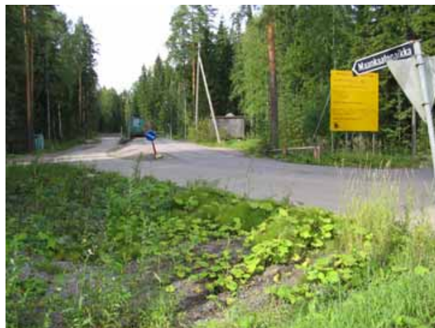
■ Kuva 6.16. Nykyinen liittymä ja vaaka-asema.
