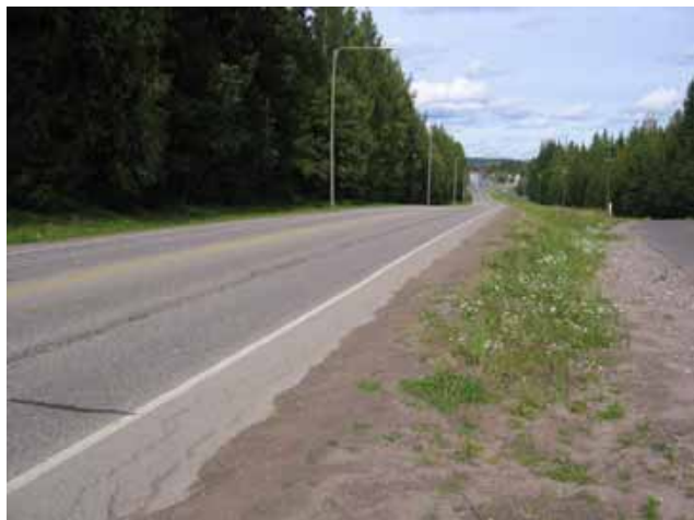
■ Kuva 6.17. Kuva mahdollisesta uudesta liittymän paikasta (VE1) keskustan suuntaan.
