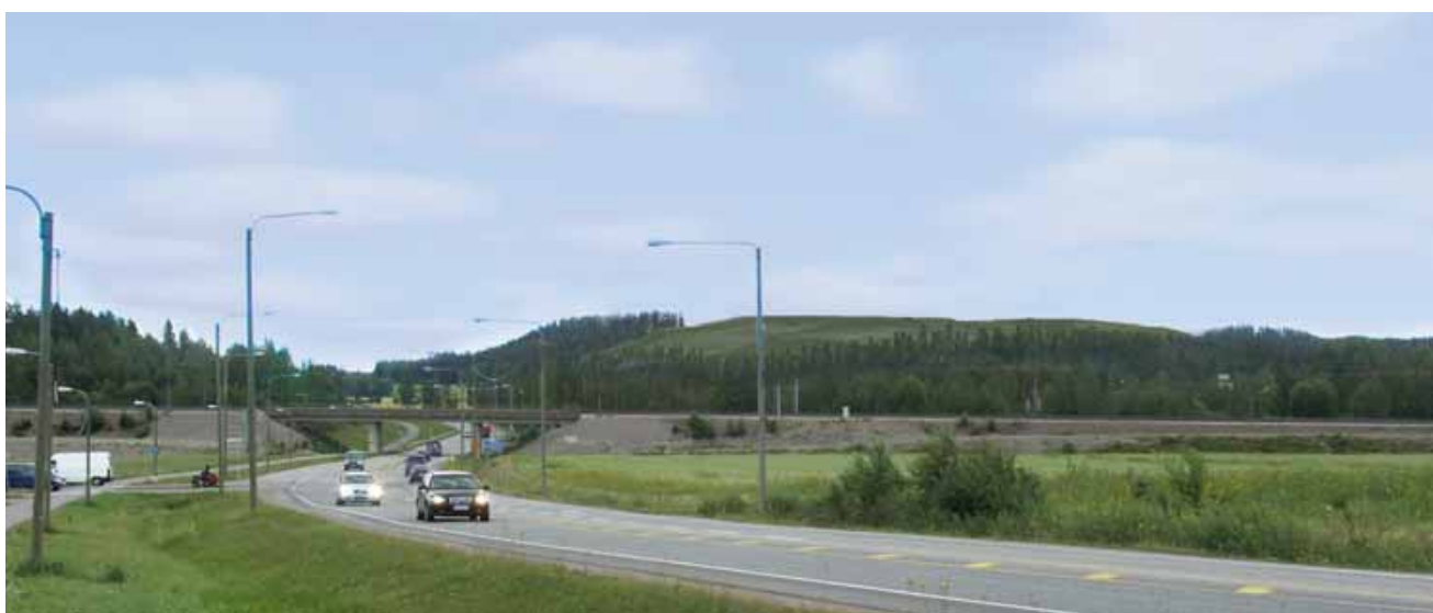
■ Kuva 6.13. Täyttömäki eri vaiheissaan Ala-Okeroistentieltä nähtynä Hennalankadun kohdalta. Ylhäällä nykytilanne, keskellä täyttö valmiina, alhaalla maisemointi toteutettu.
