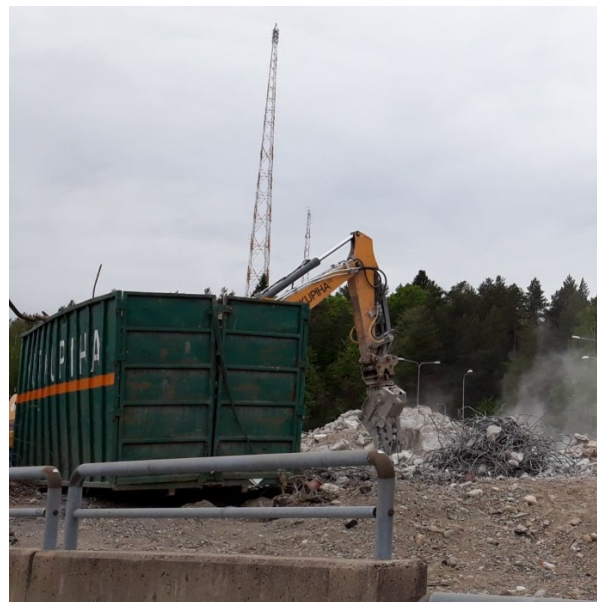
Kuva 7. Kierrätyspuistossa käsitellään mm. rakentamisessa ja purkamisessa syntyviä jätteitä.
