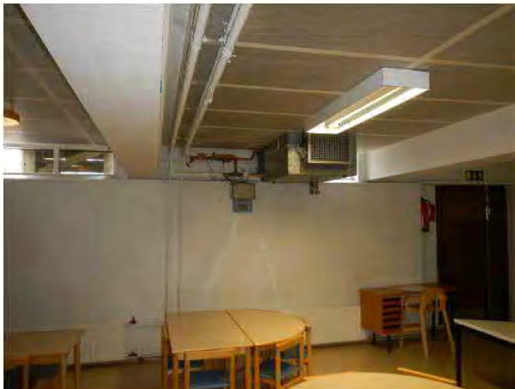
Rukoushuoneen ruokasalin IV- kone on teknisen käyttöään lopussa.
