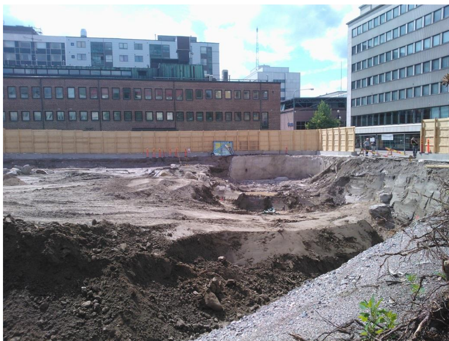
Kuva 1. Yleiskuva alatorilta Vapaudenkadun suunnalta.
