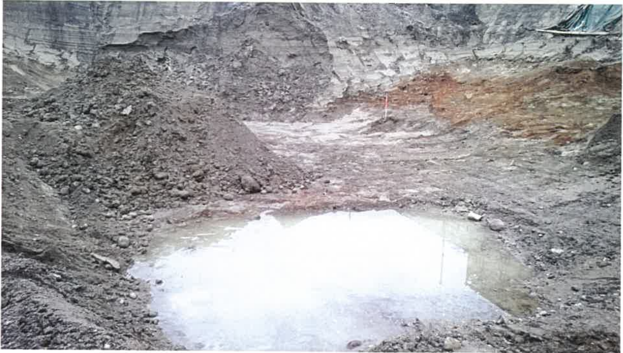
Kuva 1. Pima-kaivanto. Kuva otettu noin kohdalta 4 1 / 2 / E suuntaan luode. Oikeassa yläkulmassa, missä näkyy pressun alareuna, on Vapaudenkadun puoleinen kaivuuluiska.
