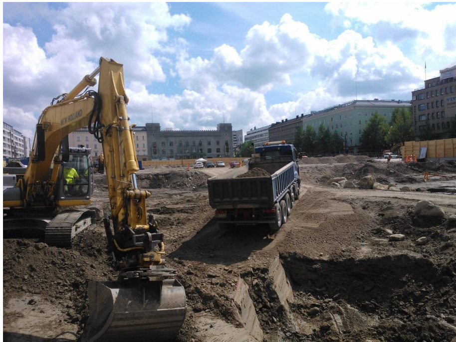
Kuva 2. Pilaantuneen maan kuormaaminen alatorilla.
