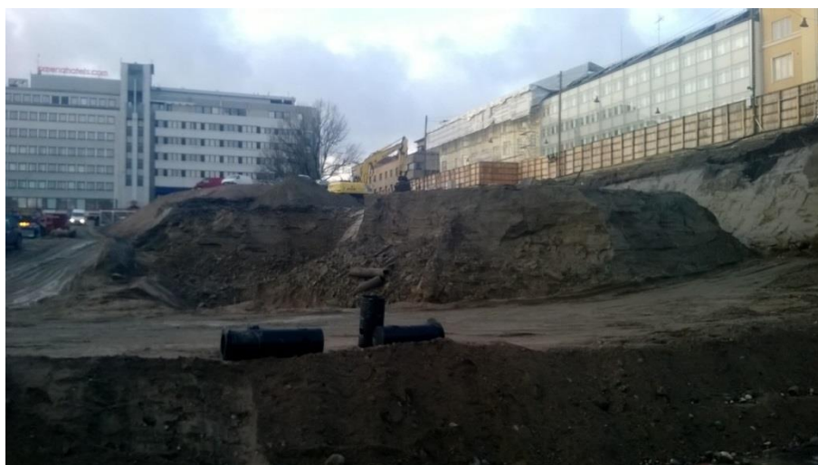
Kuva 4. Yleiskuva työmaalta torikadun suunnalta.
