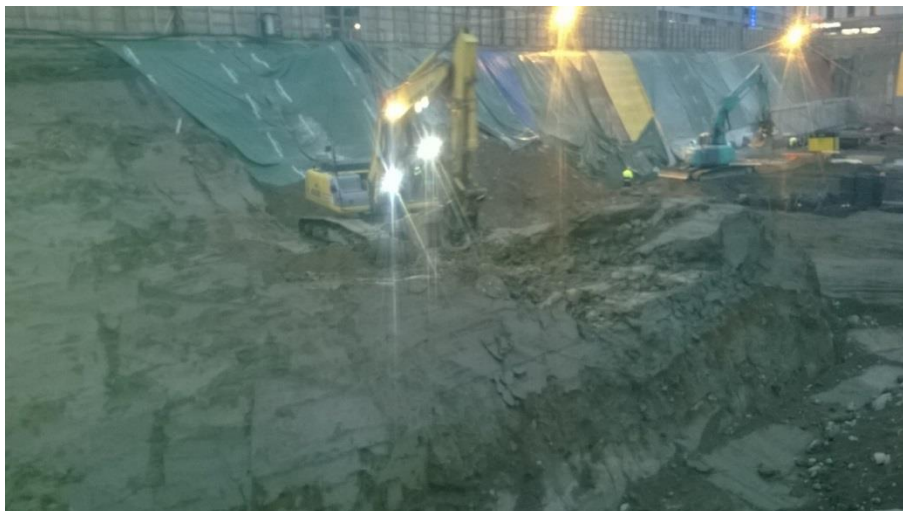
Kuva 4. Pilaantuneen maan kaivuu anturalinjan 3 kohdalla.
