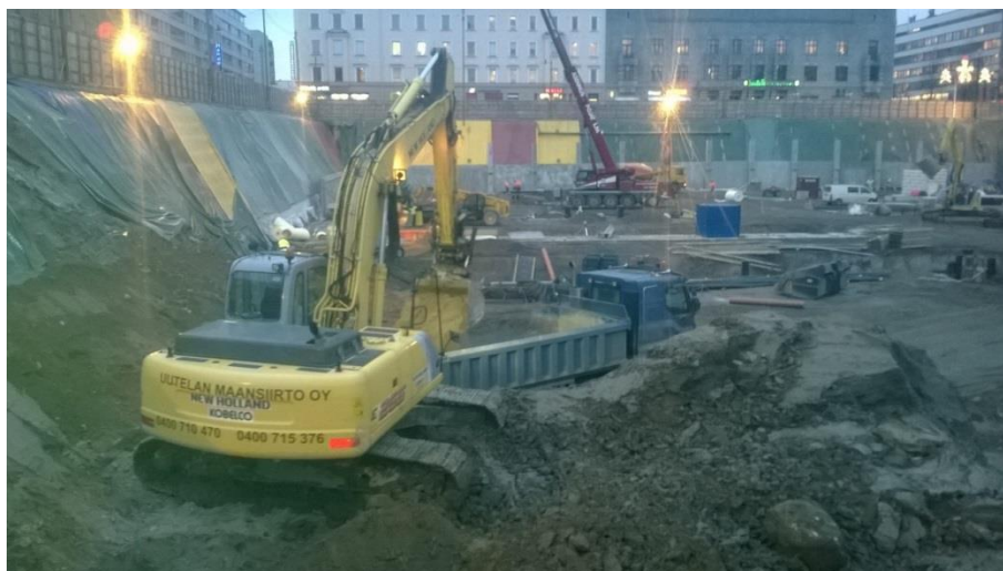
Kuva 3. Pilaantuneen maan kuormaus kaupatorilla.
