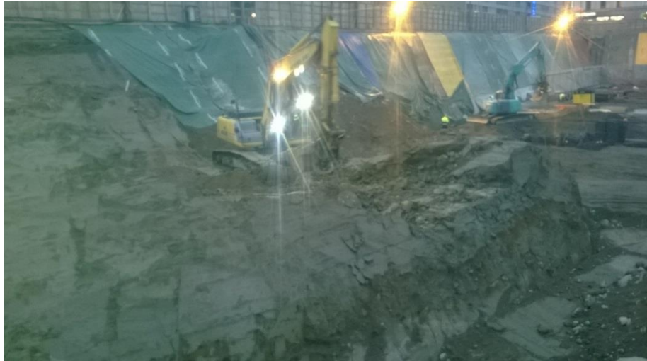
Kuva 4. Pilaantuneen maan kaivuu anturalinjan 3 kohdalla.
