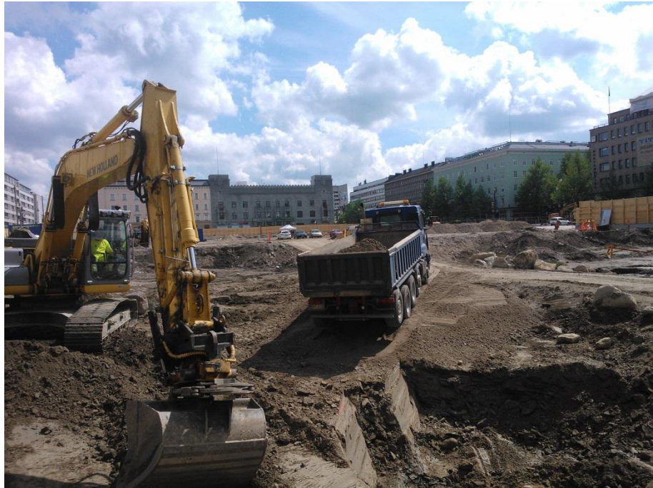
Kuva 2. Pilaantuneen maan kuormaus alatorilla.
