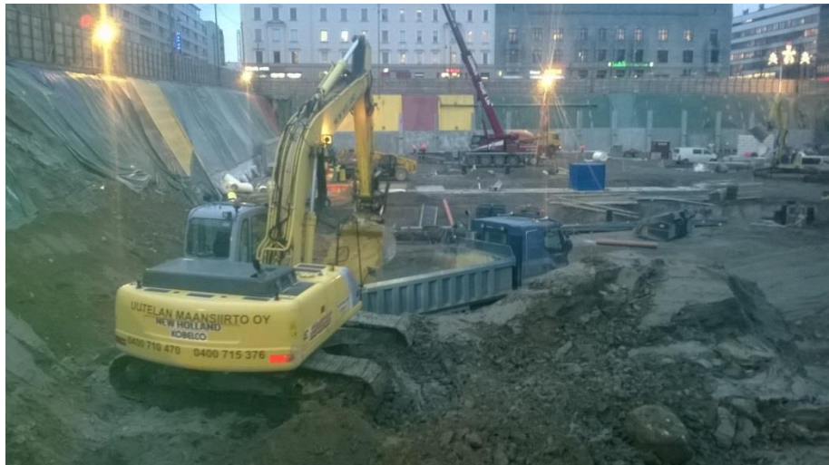
Kuva 3. Pilaantuneen maan kuormaus kaupatorilla.
