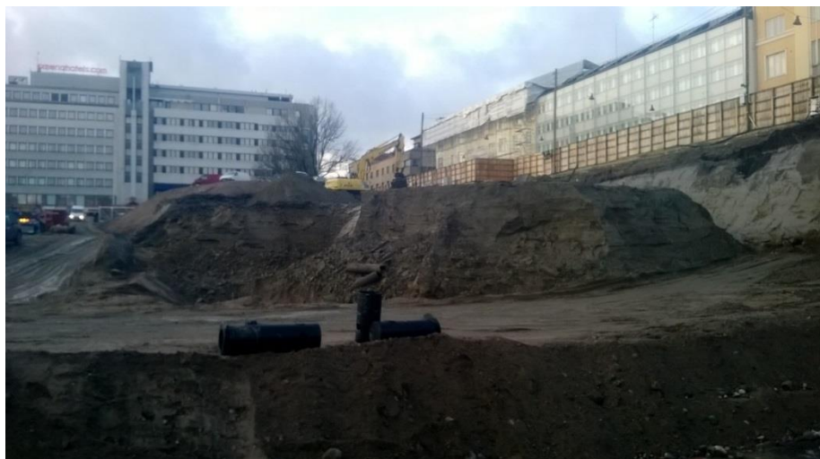
Kuva 4. Yleiskuva työmaalta torikadun suunnalta.
