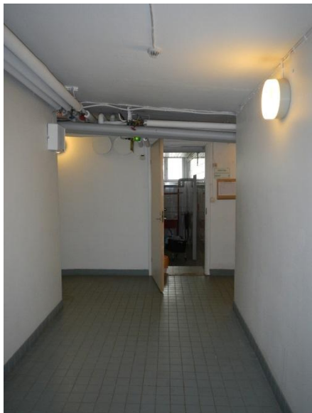
Yleiskuva kellarin käytävästä.
