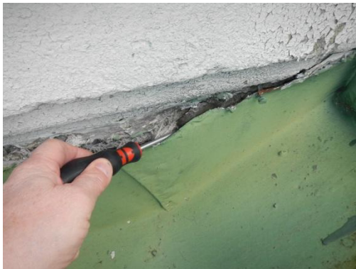
Ylösnosto ei ole tiivis, vesi pääsee peltikatteen taakse.
