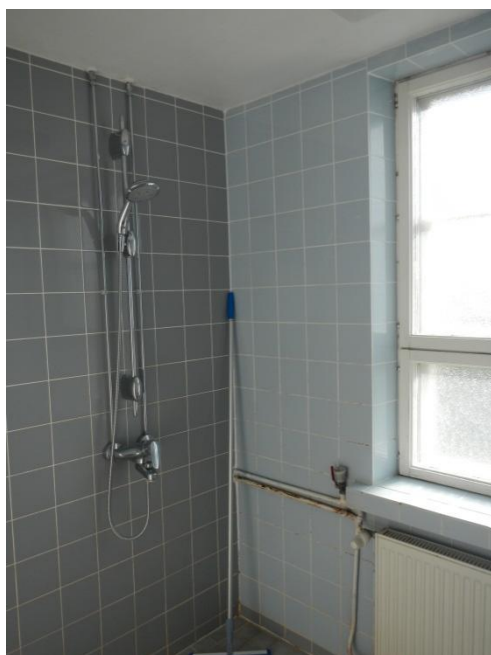
Yleiskuva yhteisessä käytössä olevasta suihkuhuoneesta. Seinien ja lattioiden laattasaumat lohkeilevat.
