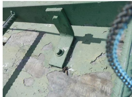
Räystäslaudoituksessa on lahoa. Kiinnitys on tehty pellin läpi.
