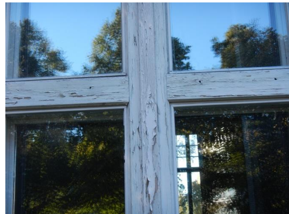
Yleiskuva asuinhuoneen ikkunasta. Ikkunan maalaus lohkeilee, eikä suojaa puuta enää kunnolla.
