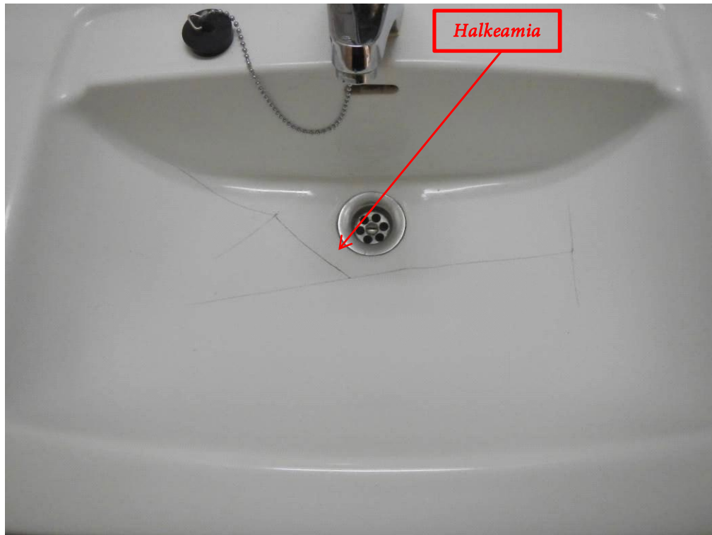
Kiinteistön vesi- ja viemärikalusteita.
