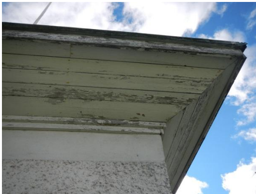
Räystäslaudoituksessa on lahoa. Kiinnitys on tehty pellin läpi.
