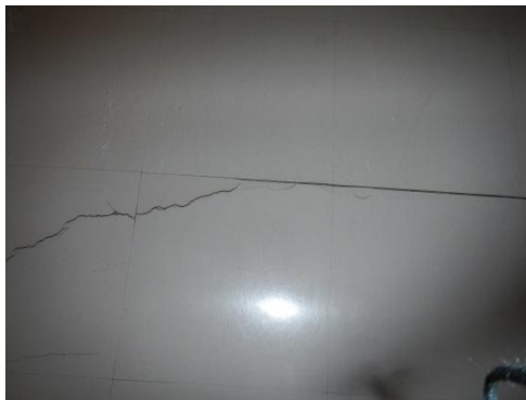
Majoitustilan käytävien lattiassa on halkeamia. Yleiskuva kellarin käytävästä.
