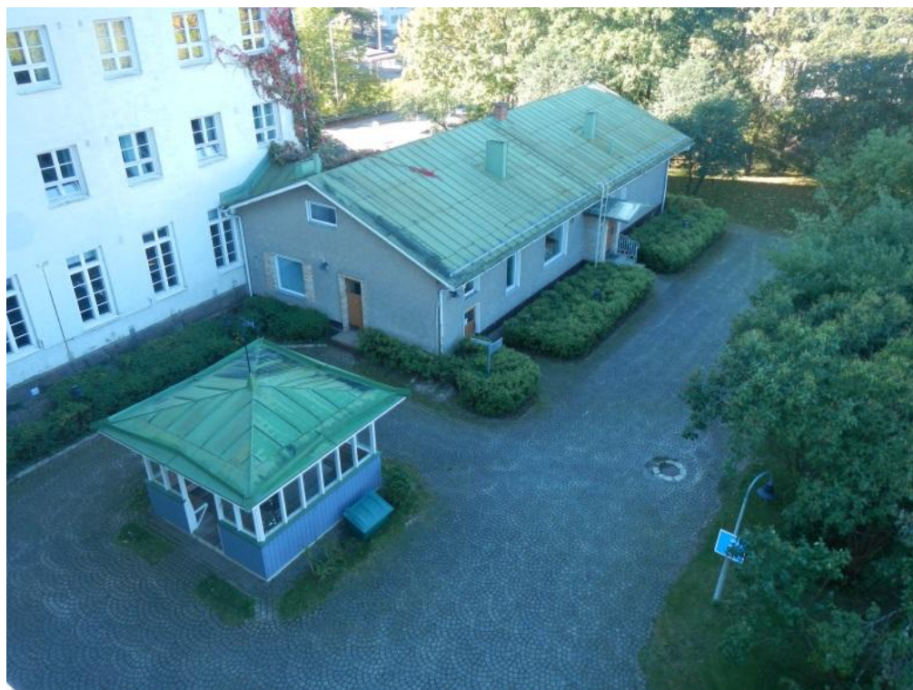
Yleiskuva katolta (1950-luvun rakennus).
