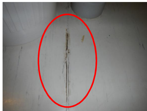
Yleiskuva kylpyhuoneesta. Muovimaton sauma on revennyt. Vesi pääsee lattiarakenteen sisään.
