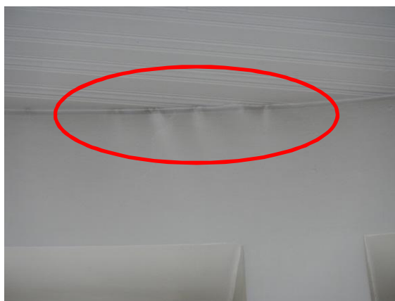
Yleiskuva ruokailutilasta. Ruokailutilan katonrajassa on ilmavuoto.
