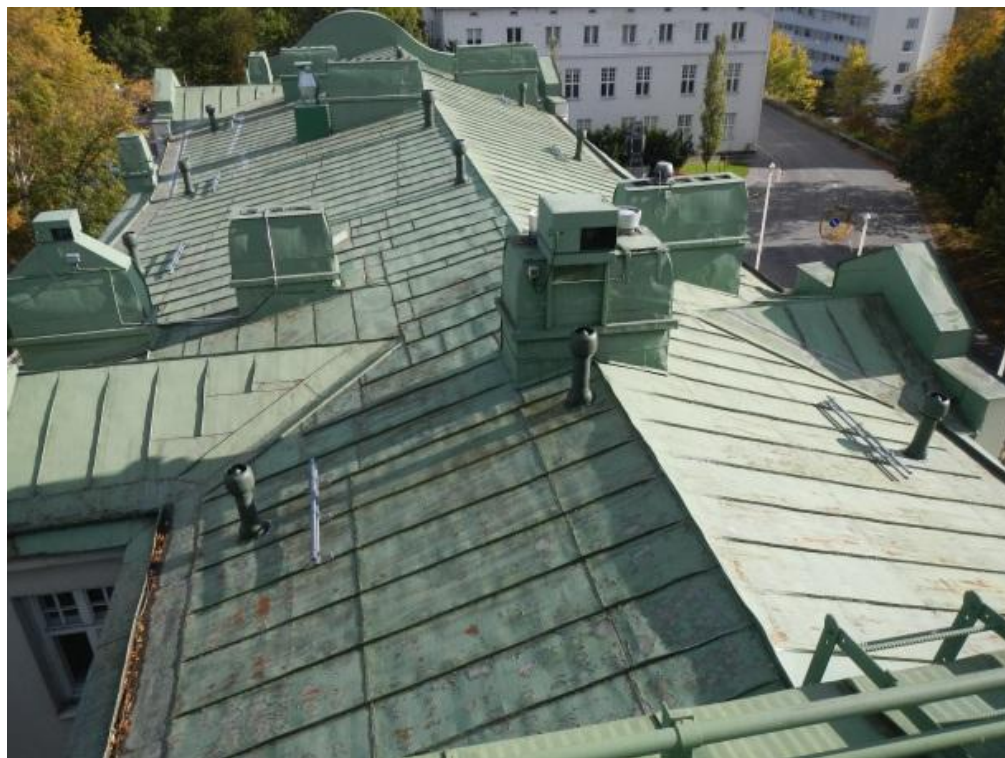
Yleiskuva katolta. Katto on tyypillinen palapeltikatto.
