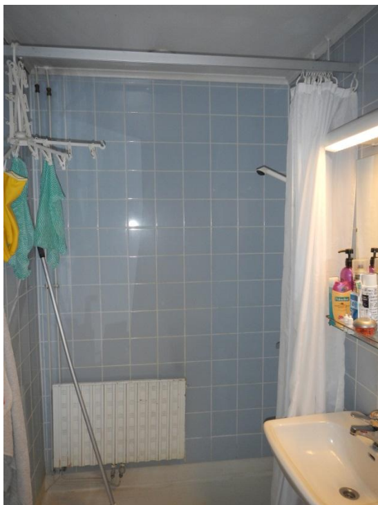
Yleiskuva kylpyhuoneesta. Muovimaton sauma on revennyt. Vesi pääsee lattiarakenteen sisään.
