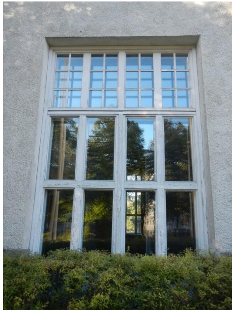
Yleiskuva asuinhuoneen ikkunasta. Ikkunan maalaus lohkeilee, eikä suojaa puuta enää kunnolla.
