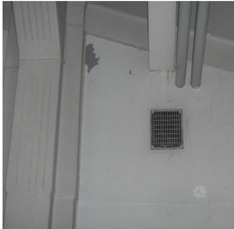
Alkuperäinen poistoilmaventtiili.
