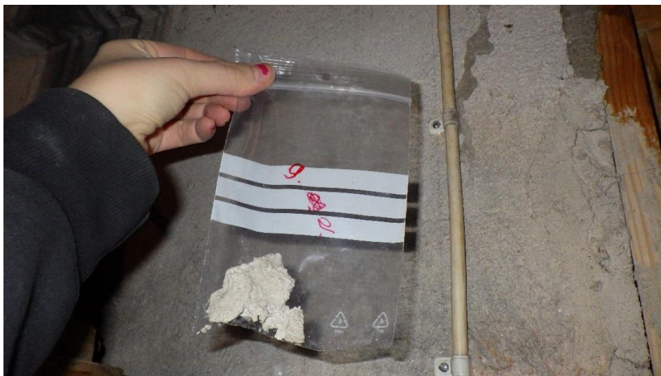
Kuva 11. Hormin rappaus (näyte 9). Ei sisällä asbestia.
