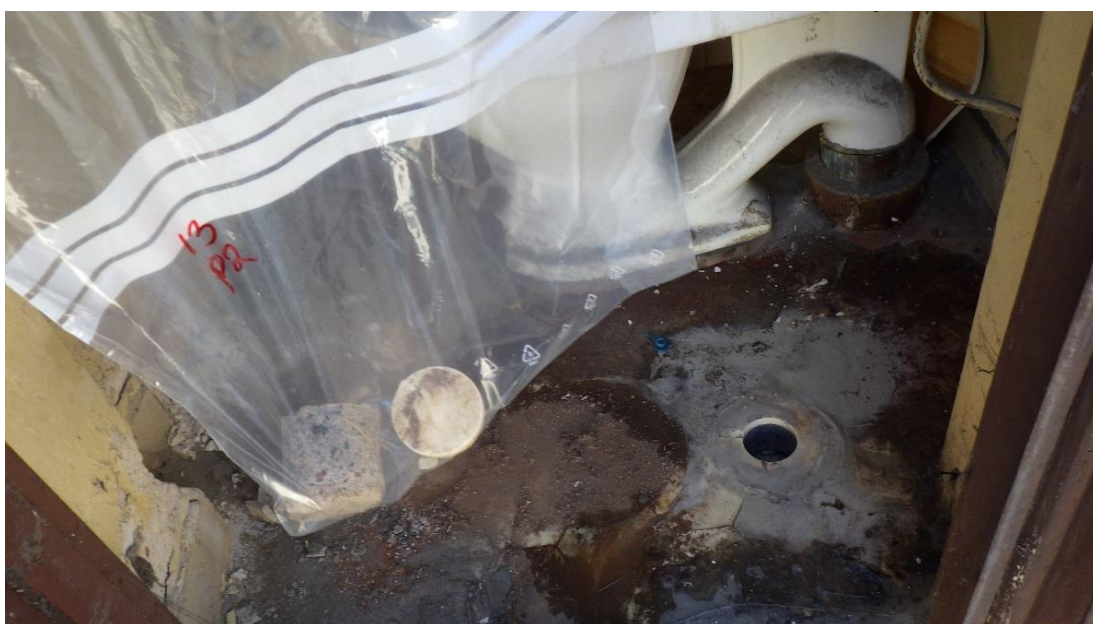
Kuva 14. WC:n lattian kuusikulmalaatta (näyte 13) ei sisällä asbestia. Lattian betoni porausnäyte P2, ei analysoitu.
