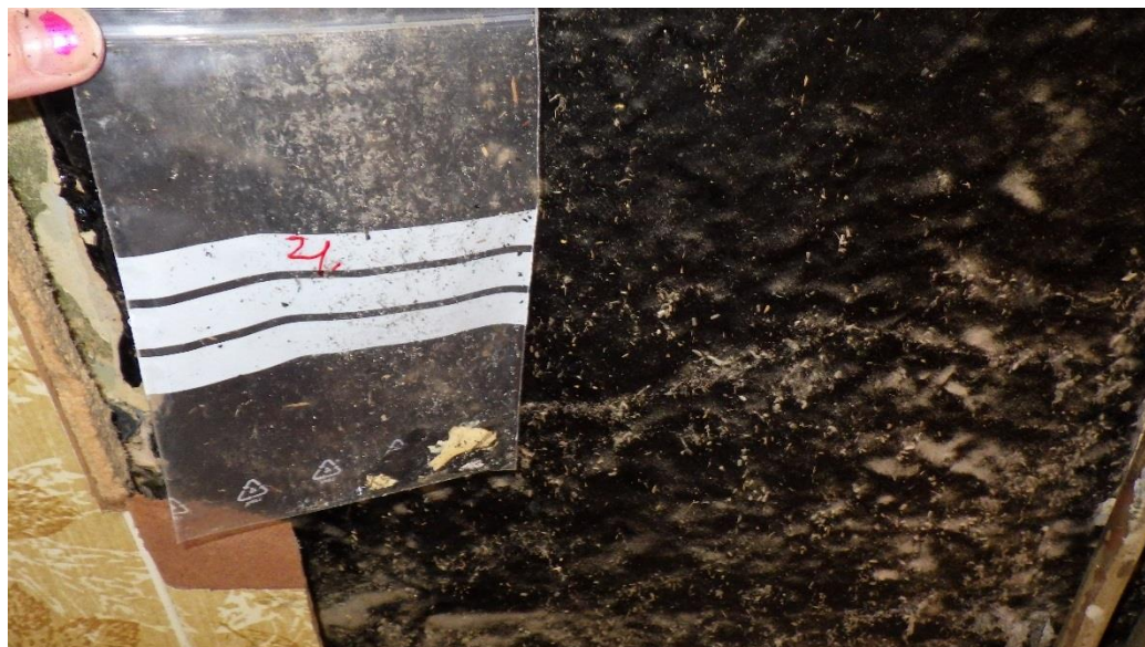
Kuva 7. Seinän bitumisively 2.krs (näyte 4). Ei sisällä asbestia. PAH(16)-yhdistepitoisuus on vähäinen.
