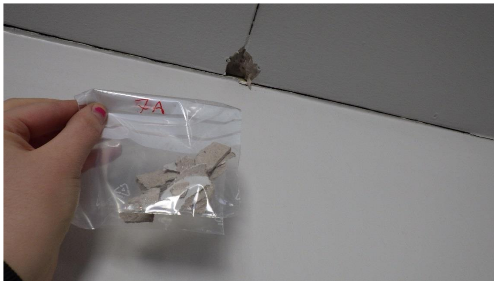
Kuva 9. Alempi (A) ja ylempi (B) kattolevy, 1 krs. (näyte 7A ja 7B). Ei sisällä asbestia.
