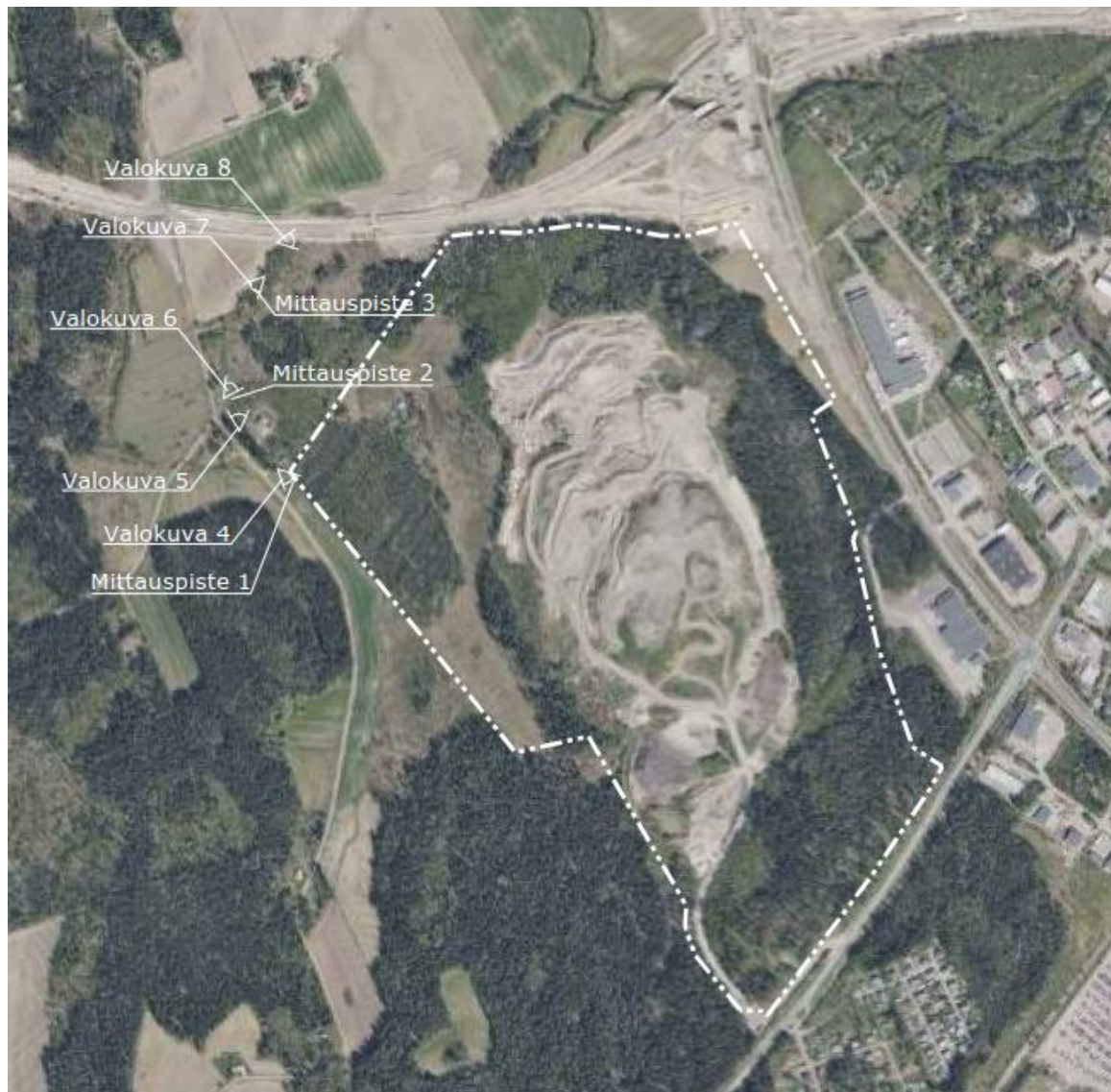
Kuva 2. Ilmakuva kohdealueesta. Ilmakuvassa näkyvät selkeästi maanvastaanottoalue sekä kehätien työmaa. [Lahden kaupunki 5/2019]
