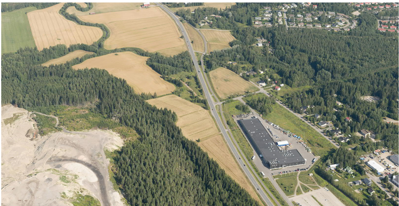
Kuva 7. Viistoilmakuva suunnittelualueelta vuodelta 2014 ennen Lahden eteläisen kehätien rakentamista
