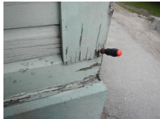
Rukoushuoneen seinän maalaus lohkeilee, paikoitellen puu on lahoa tai pinta on pehmeää.
